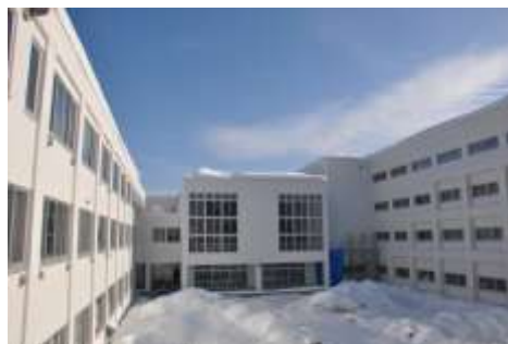
西側2階廊下より校舎の全景
